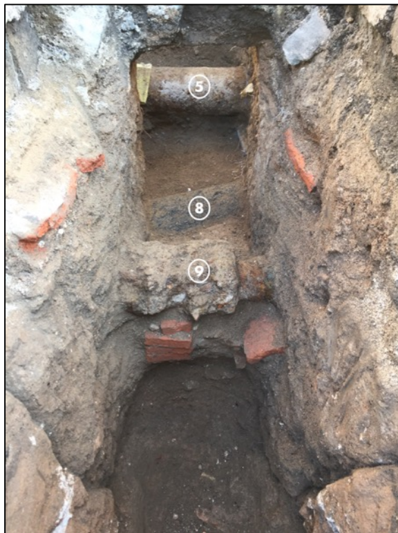
Fotografia 9. Vista en secció dels diversos serveis localitzats. 5.Gas; 8.Indeterminat; 9.Aigua.
