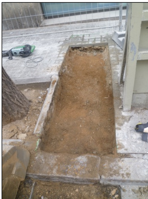
Fotografia 34. Vista nivell de sauló documentat a la vorera UE202.
