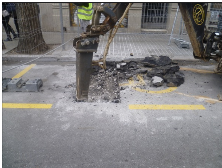
Fotografia 66. Rebaix paviment asfalt calçada UE403.
