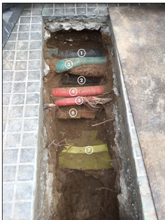
Fotografia 48 . Vista en secció dels diversos serveis localitzats.
