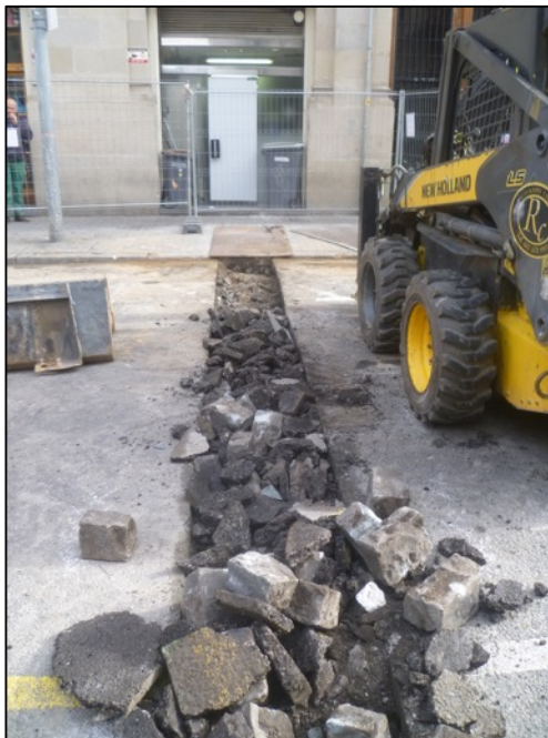
Fotografia 12. Aixecament del paviment de llambordes UE104.
