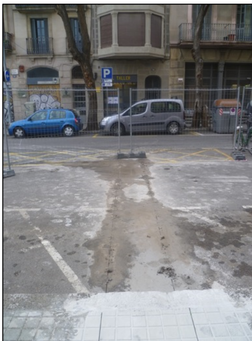
Fotografia 10. Vista de la Cala 1 tram de la calçada.
