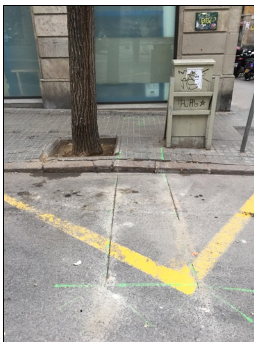
Fotografia 30. Vista calçada amb paviment d'asfalt UE203..
