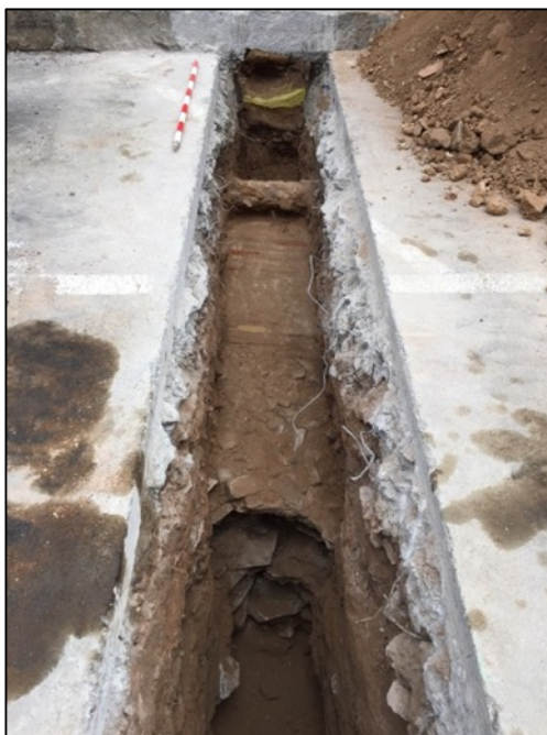
Fotografia 61. Vista general estructura s. XIX UE309.
