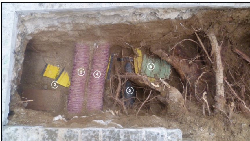
Fotografia 39. Vista en planta dels diversos serveis localitzats a la vorera. 2.Electricitat; 3.Tub corrugat morat; 4.Tub corrugat morat; 5.Aigua; 6.Electricitat.
