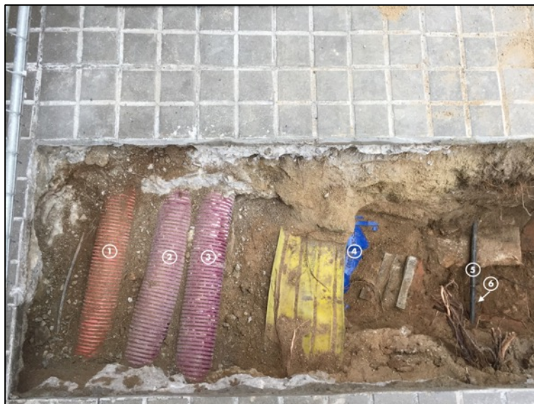
Fotografia 73. Vista en planta serveis localitzats a la vorera. 1.Electricitat (senyals trànsit); 2.Tub corrugat morat; 3.Tub corrugat morat; 4.Aigua; 5.Electricitat (enllumenat públic); 6.Electricitat.
