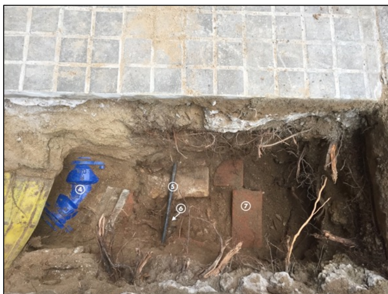
Fotografia 74. Detall serveis localitzats a la vorera. 4.Aigua; 5.Electricitat (enllumenat públic); 6.Electricitat; 7.Electricitat.
