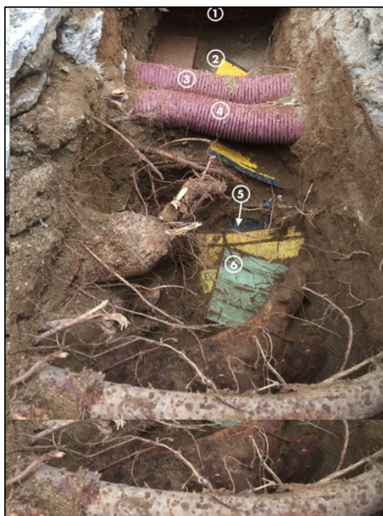
Fotografia 38. Vista en secció dels diversos serveis localitzats a la vorera. 1.Electricitat; 2.Electricitat; 3.Tub corrugat morat; 4.Tub corrugat morat; 5.Aigua; 6.Electricitat.
