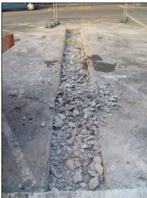
Fotografia 50. Paviment d'asfalt de la calçada UE300 un cop repicat per la màquina.
